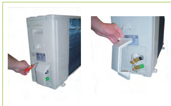
Obr. 32: Demontáž plastových krytů
