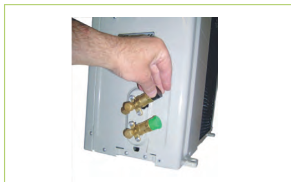
Obr. 33: Demontáž ochranných krytek
