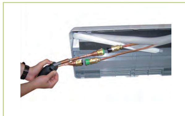
Obr. 37: Instalace vnitřní jednotky
