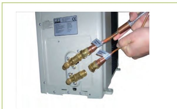
Obr. 35: Pozice rychlospojek
